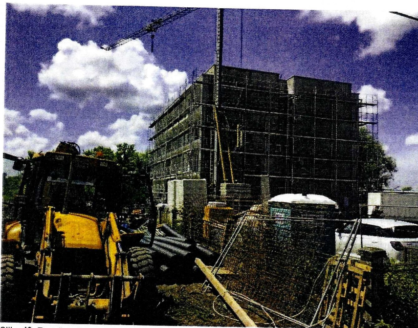
Slika 43. Započeta izgradnja višestambenih zgrada u okviru OPKK projekta Izvor: ZPUSMŽ
